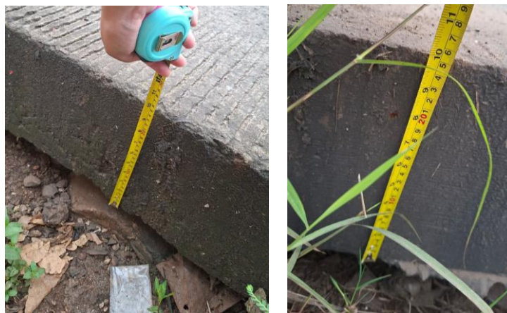
Gambar 3. Tebal Perkerasan Eksisting (Sumber : Penulis, 2026)
